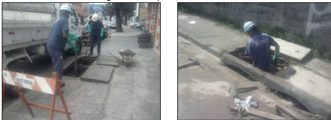
Figura 50 – Limpeza das bocas de lobo
