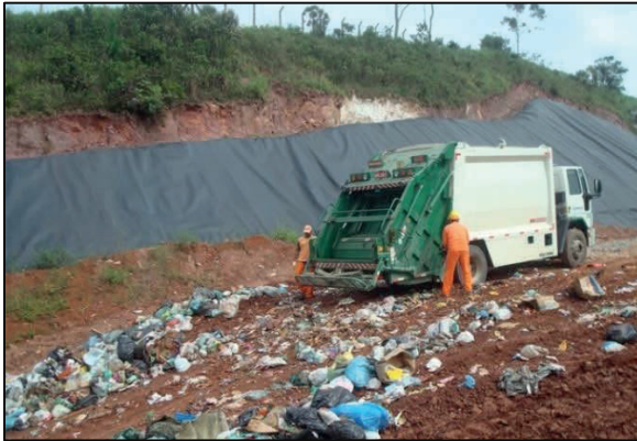
Figura 18 – Descarregamento dos resíduos na área do aterro da CTR Santo André
