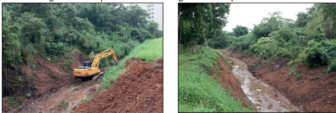
Figura 51 – Limpeza dos rios e córregos do município de Santo André
