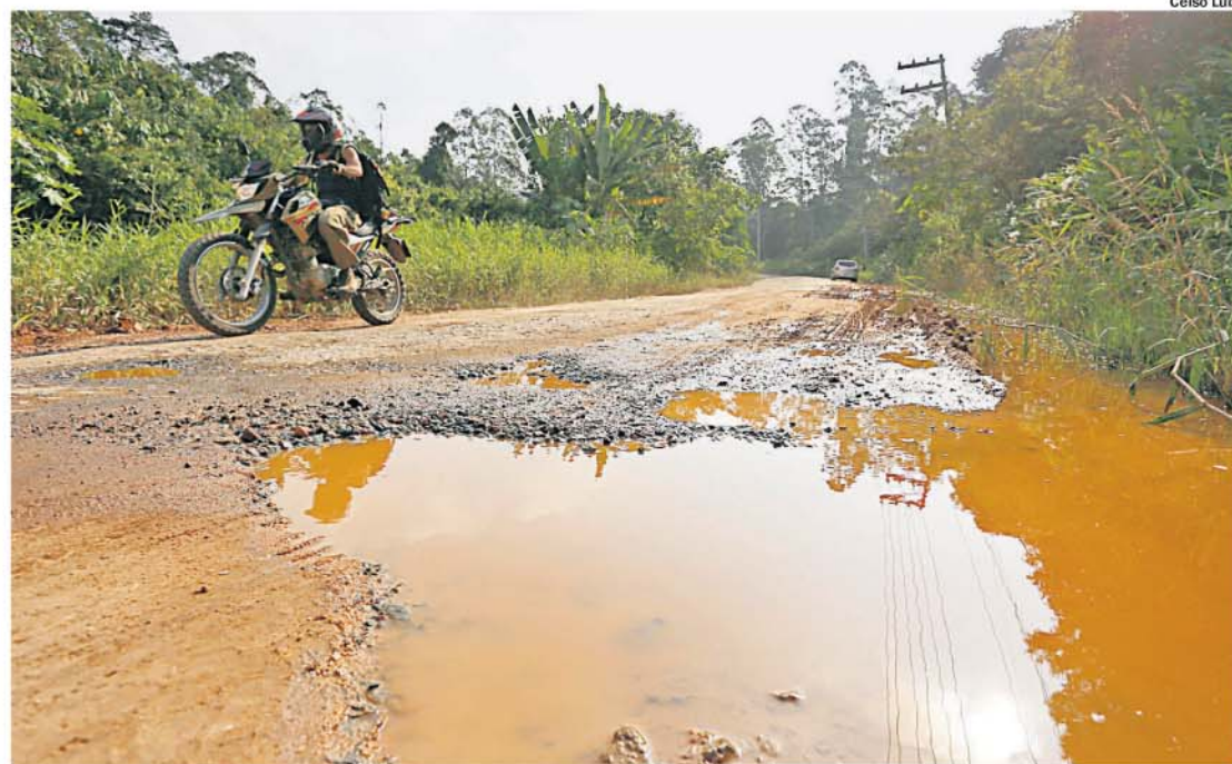
TRANSTORNO. Comunidade reclama, além dos buracos, da falta de iluminação e das pragas urbanas
